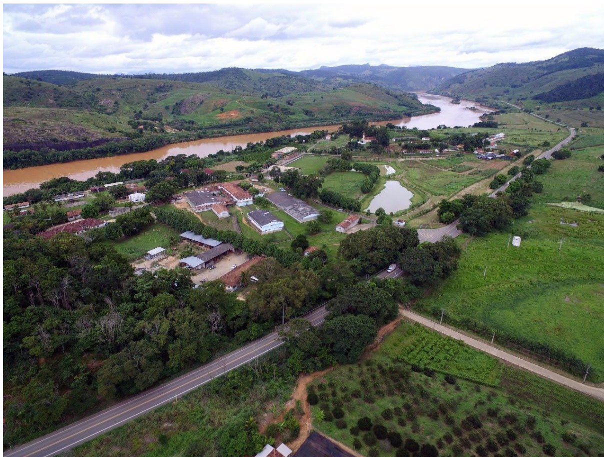
Figura 1 - Vista aérea do campus Itapina
